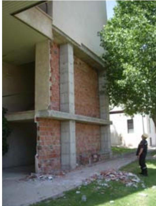
**Figura 6.20.** Daños a cerramientos de plantas bajas en un edificio de vivienda con locales comerciales de gran esbeltez (izquierda) y en el hospital Rafael Méndez. (derecha).
