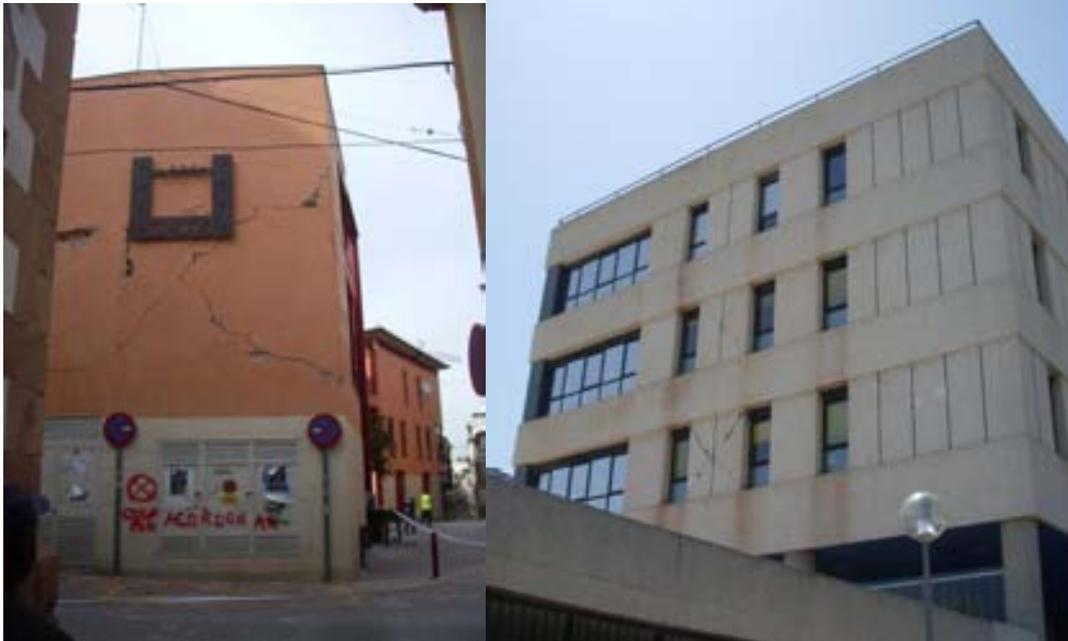
**Figura 6.37.** Grietas por cortante en forma de aspa en el cerramiento de un edificio público de muy reciente construcción en Lorca. A la derecha aspas de cortante en el hospital Rafael Méndez.
