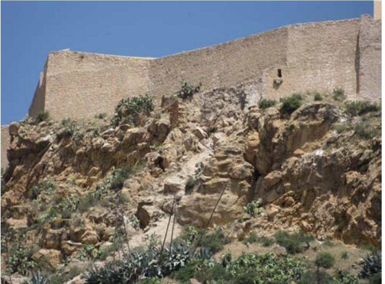
**Figura 5.8.7** Desmoronamiento de un antiguo murete de contención adosado a la muralla exterior del castillo de Lorca en su falda N. Esta inestabilidad alertó a los habitantes de las viviendas situadas más abajo, preguntándonos in situ si era seguro volver a sus viviendas.
