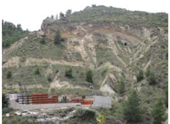
**Figura 5.8.11** Vista de la ladera en un depósito de bombonas de gas en la carretera del pantano de Puentes. No se han identificado inestabilidades del terreno atribuibles a los terremotos del 11 de Mayo, aunque el desplome del murete de bloques de hormigón sí se atribuye a estos.
