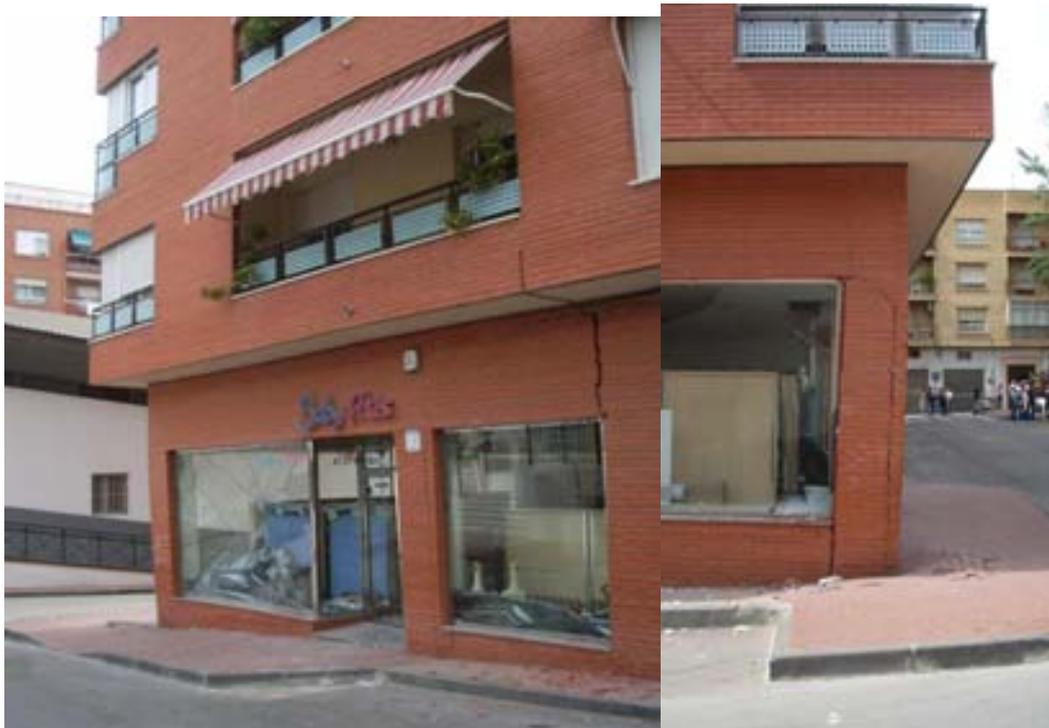
**Figura 6.34.** Torsión motivada por el efecto rigidizante de los muros medianeros de un edificio de esquina con grandes deformaciones permanentes en el pilar de la esquina más alejada del centro de rotación. Este edificio se derrumbó a los pocos días de realizar las fotografías.
