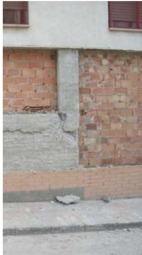
**Figura 6.24.** Dos tipos de pilares cortos dañados en edificios de Lorca.
