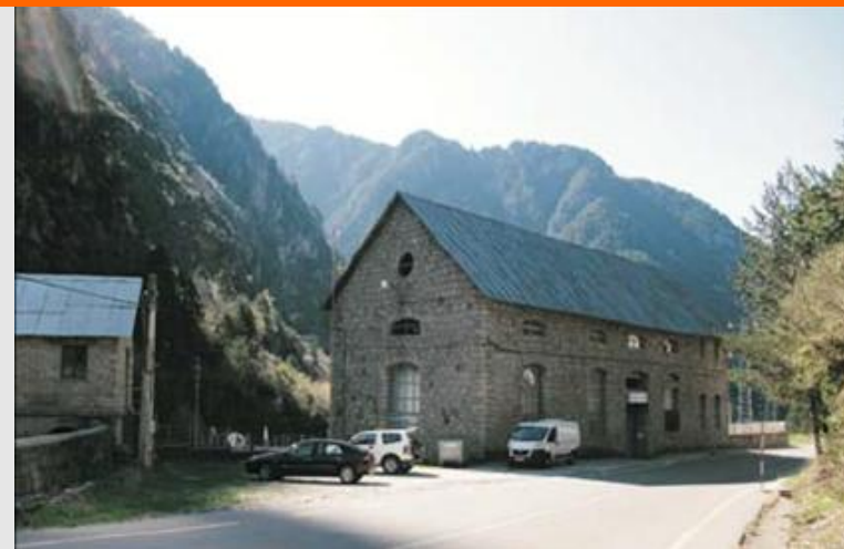
Sala de emergencia secundaria
